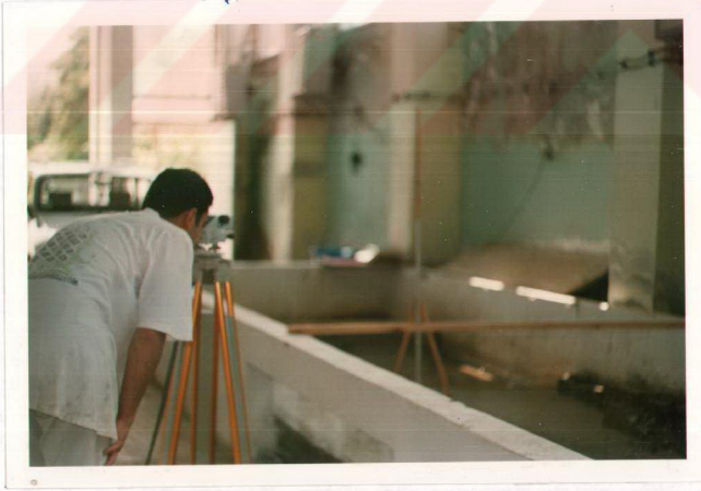
Ek Şekil 3.2 Eğitim düzeltme ve taban malzemesi için nivelman yapılması
