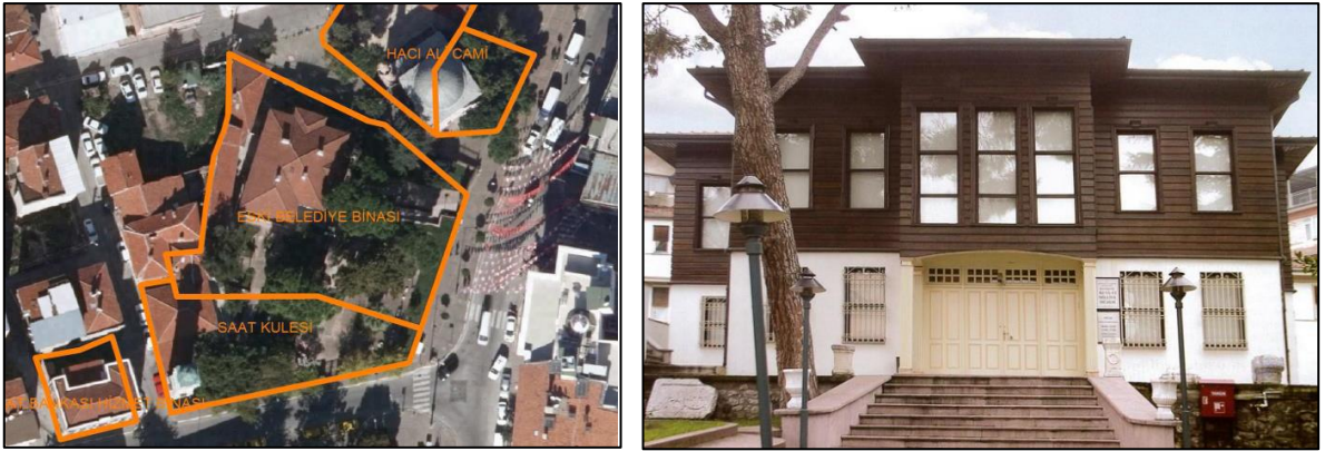
Şekil 47. Eski belediye binasının konumu ve fotoğrafı
