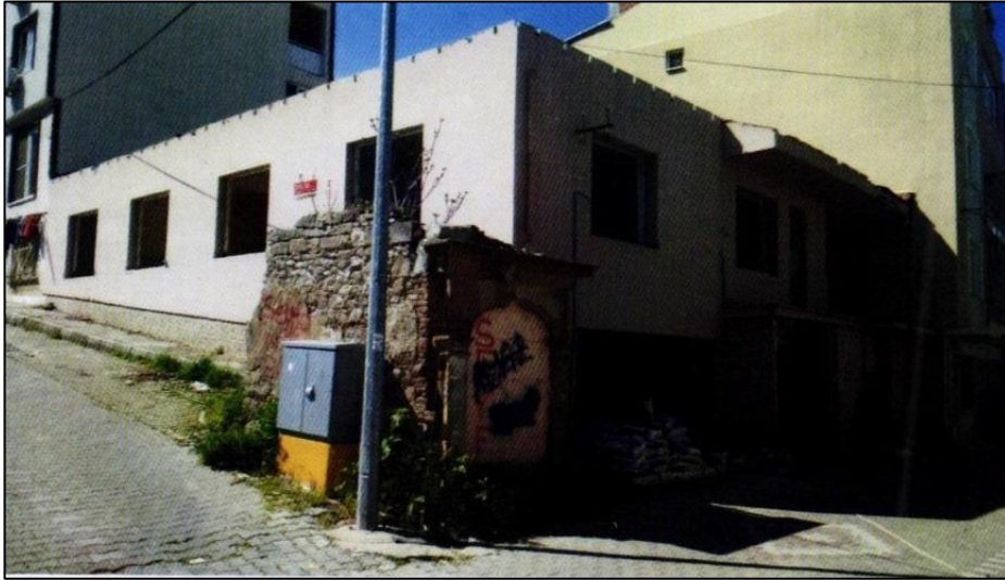
Şekil 83. Yeni yapılaşma öncesi durumu
