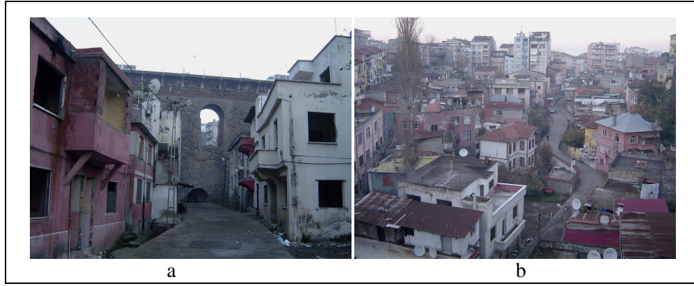
Şekil 13. a. (1 no'lu bakış yönü) Vadiden Zağnos Köprüsü'ne bakış. b (2 no'lu bakış yönü) Zağnos Köprüsü'nden kuzeye bakış
