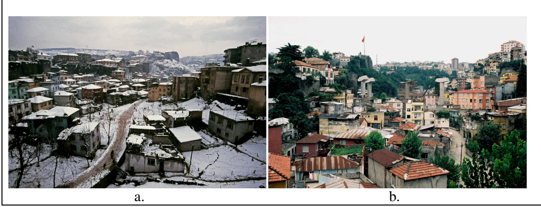
Şekil 12. (4 no'lu bakış yönü) a. Zağnos Köprüsü'nden güneye Tanjant Köprüsü inşa edilmeden b. Tanjant Köprüsü inşa edilirken (M. Reşat Sümerkan'ın arşivinden)
