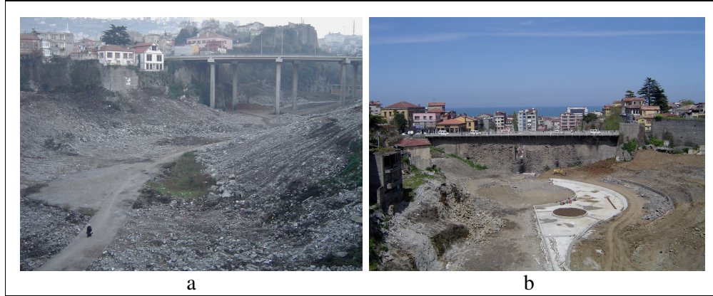
Şekil 16. a. (3 no'lu bakış) yıkım sonrası Zağnos Vadisi. b. (7 no'lu bakış yönü) b. dönüşüm sonrası Zağnos Vadisi
