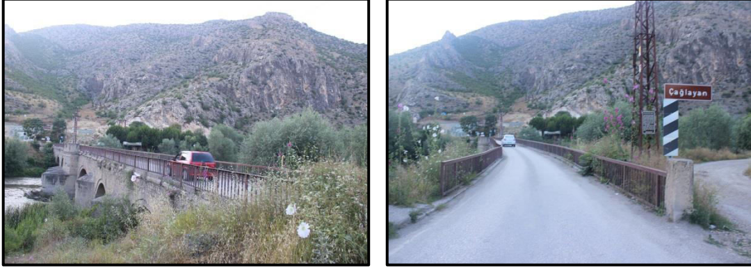
Şekil 70. İltekin (Çağlayan) Köprüsü'nden görünüm
