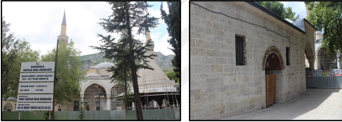
Şekil 40. II. Bayezid Camiisi ve İmaret’ten görünüm
