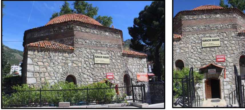
Şekil 76. Kumacık Hamamı'ndan görünüm
