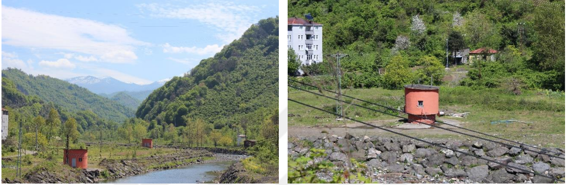
Şekil 2.20. Mevcut keson kuyularının görünümleri
