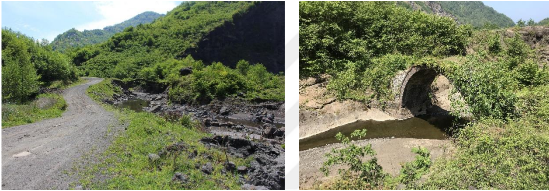
Şekil 2.28. Araştırma alanı ve yakın çevresi mevcut Hınıç Taş Kemer Köprüsü
