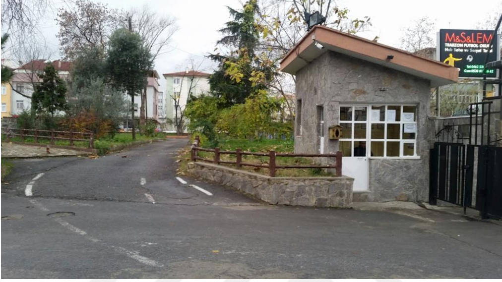
Şekil 50. Merkezi ve Teknik Anadolu Lisesi – Girişten görüntü
