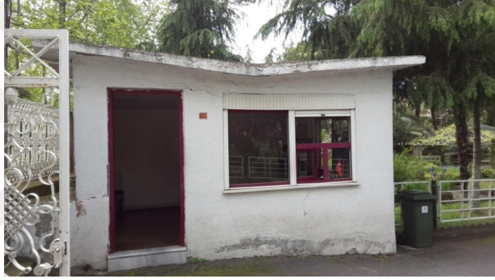
Şekil 75. Merkez Fen Lisesi güvenlik kulübesinde görünüm
