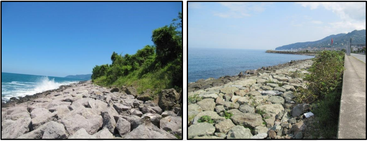
Şekil 9. DKSİY geçirilmesiyle yapılan kıyı koruma yapıları
