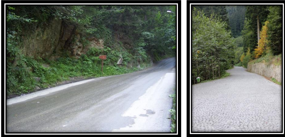
Şekil 56. Asfalt ve kırma taş kaplı yol
