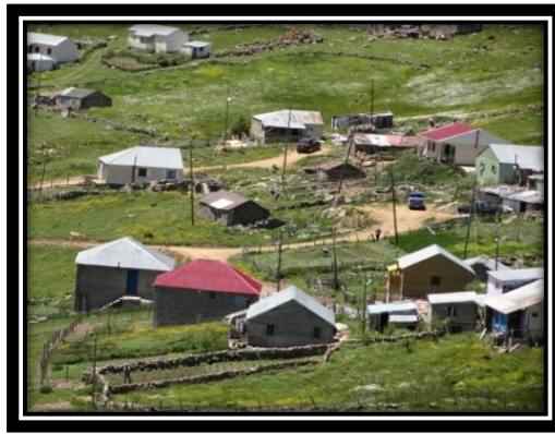
Şekil 51. Yeni inşa edilen evlerden örnekler
