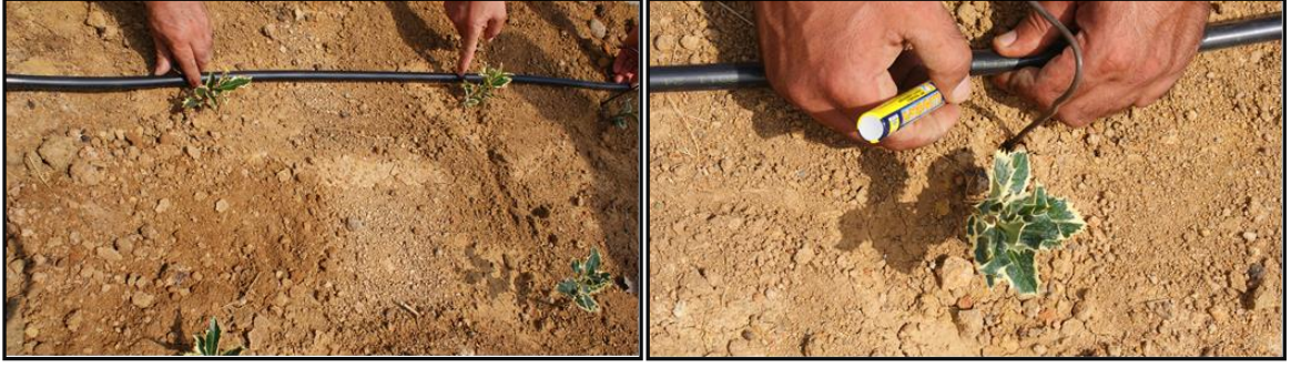
Şekil 2.11. Damla sulama sistemindeki damlatıcıların yerlerinin belirlenmesi
