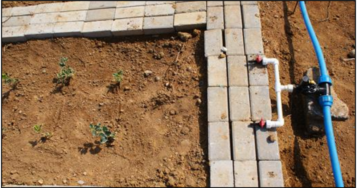
Şekil 2.12. Damla sulama sistemindeki selenoid vananın konumu
