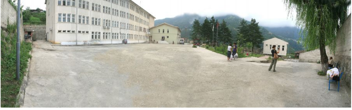
Şekil 31. Ataköy Ruh Sağlığı ve Hastalıkları Hastanesinin mevcut durumu
