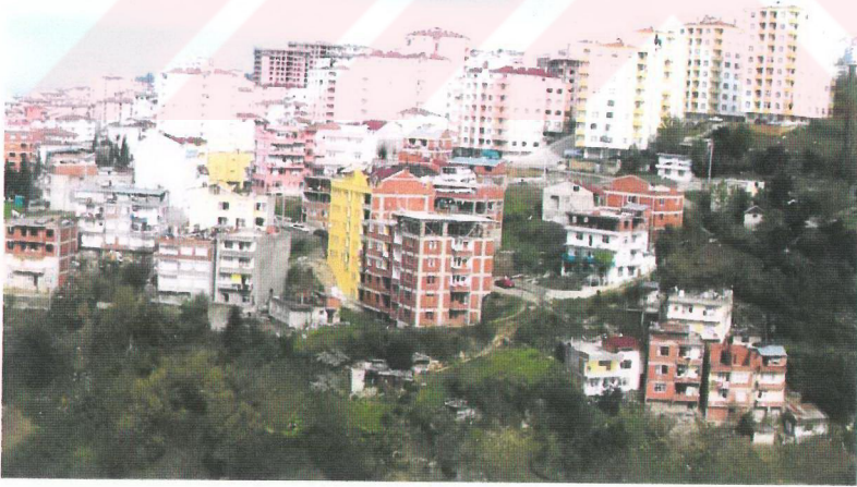
Şekil 52. Çalışma alanındaki çarpık ve yoğun yapılaşma
