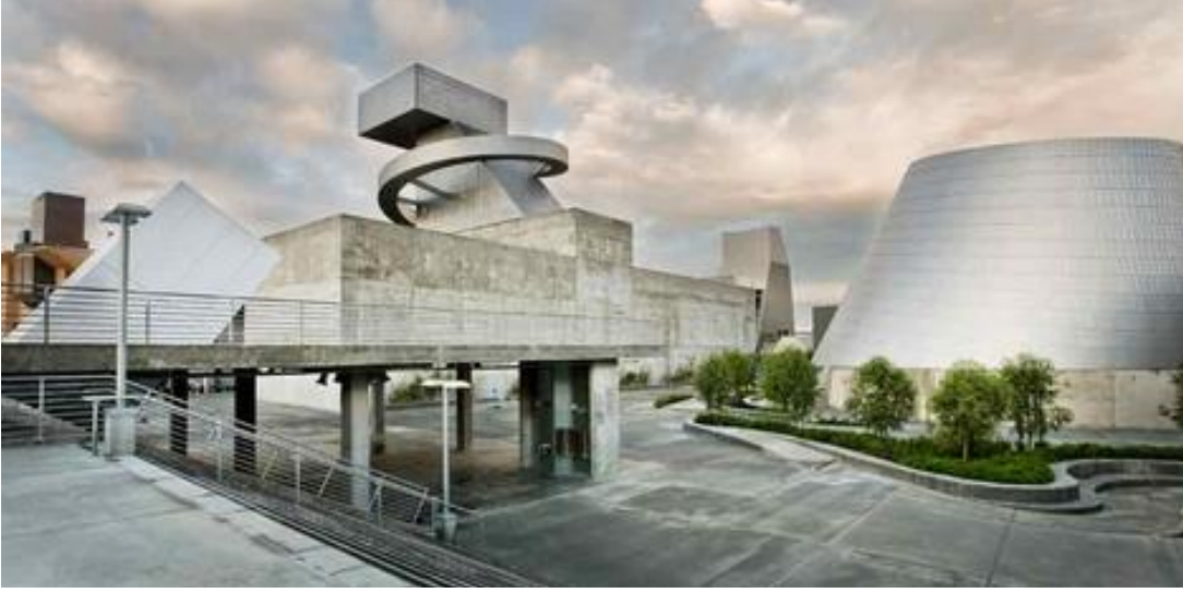
Şekil 30. Los Angeles Görsel Sanatlar Lisesi dış mekânı (URL-24)
