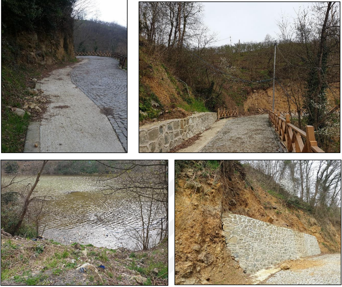
Şekil 20. Sol üstteki fotoğraf heyelanı gösteriyor, sağ üstteki fotoğraf elektrik hattını gösteriyor, sol alttaki fotoğraf göl etrafı kirlilik, sağ alttaki fotoğraf heyelan ve engelleyici duvar eksikliğini gösteriyor
