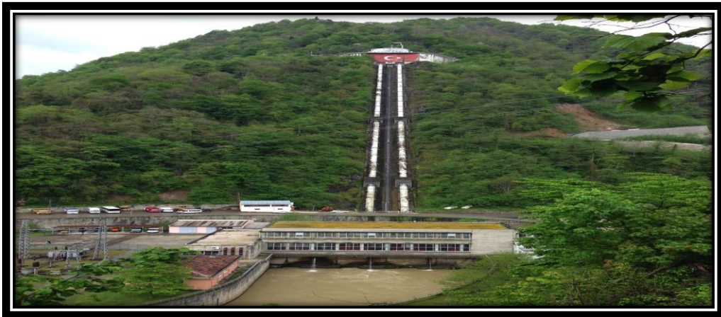
Şekil 34. Harşit Çayı üzerindeki hes tesisleri
