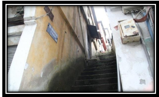
Şekil 40. Tirebolu merkeze inilen merdivenler
