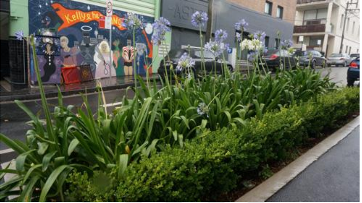
Şekil 27. Yol kenarında yağmur bahçesi (URL-21).
