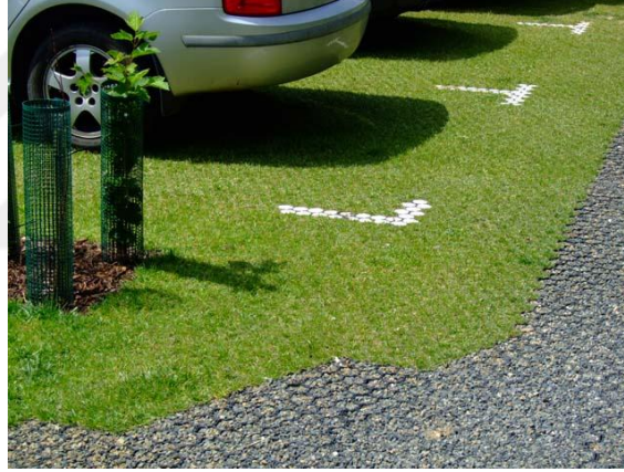
Şekil 34. Çim derzli geçirimli yüzey otopark alanı (URL-29).
