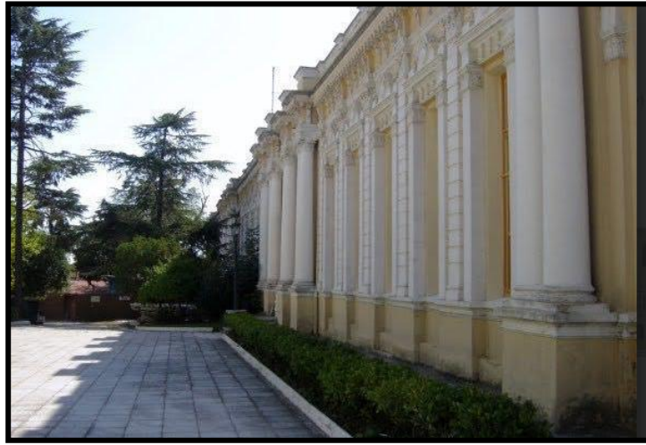
Şekil 50. Yıldız Sarayı Silahhane Binası
