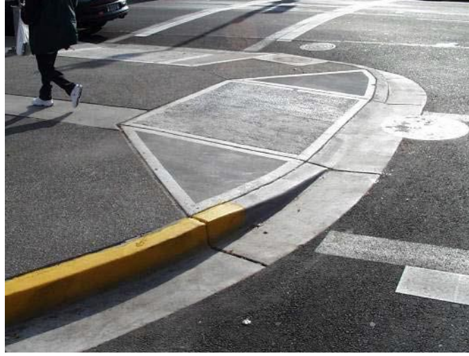
Şekil 7. Kaldırım kenarı rampası geniş, yol ile aynı seviyede ve kullanıcıları direkt yaya geçidine yönlendirmek için hizalanmış durumda (URL-14).
