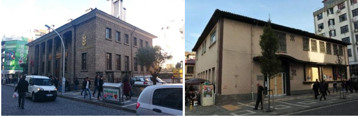
Şekil 51. Ziraat bankası ve eski merkez bankası binaları (URL-76).
