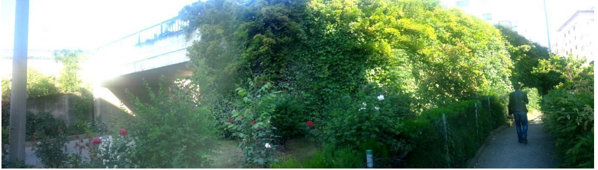
Şekil 52. Duvar önündeki toprak kısma dikilen ve tüm duvarı kaplayan Hedera helix ve Wisteria sinensis vejetasyonları
