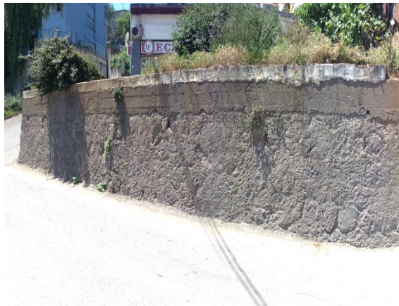
Şekil 39. Kentsel araştırma alanlarında asfalt duvar önü malzemesi
