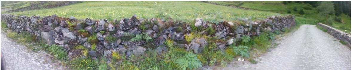
Şekil 43. Araştırma alanı içerisinde yüzeyinde en fazla tür barındıran açık derzli yığma taş duvar
