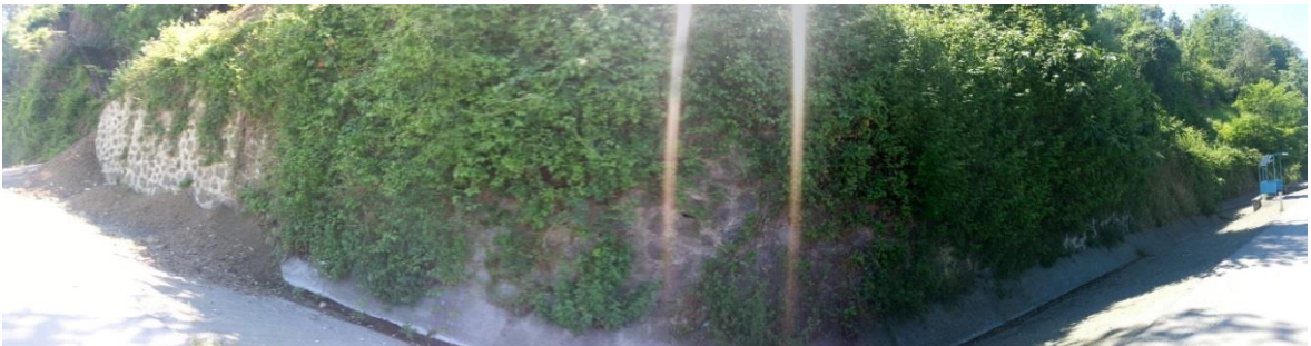
Şekil 44. Kentsel araştırma alanlarında doğal olarak bitkilenmiş duvar örneği
