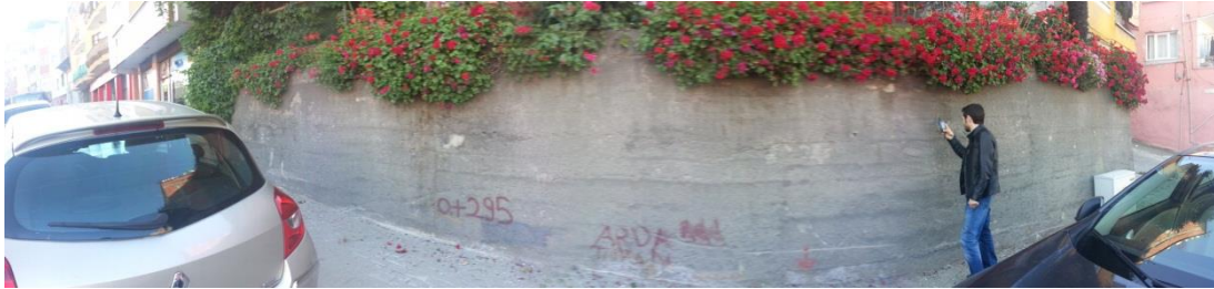
Şekil 12. Araştırma alanında belirlenen ‘Beton-Betonarme Duvar’ örneği
