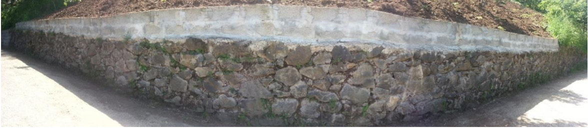
Şekil 37. Doğal taş duvar üzerine biriket ile yapılan ek yapı
