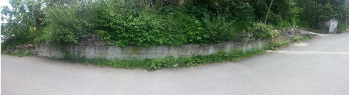
Şekil 36. Beton-betonarme duvar üzerine yığıma taşlarla yapılan ek yapı
