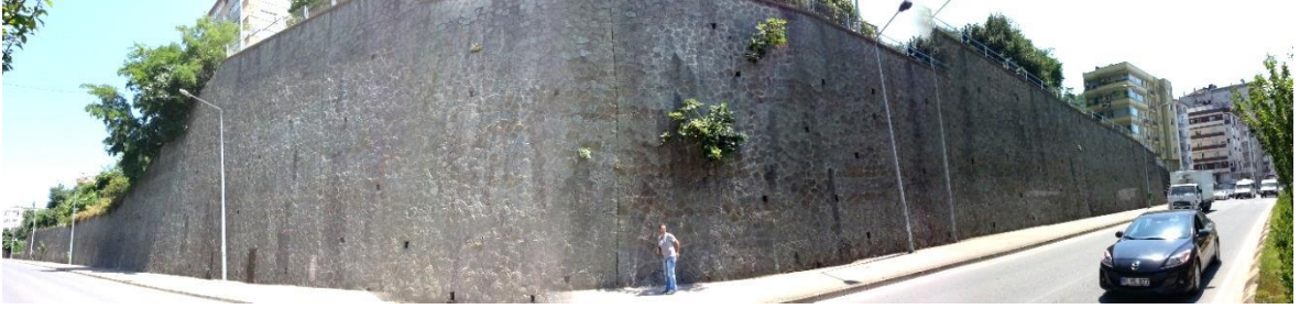
Şekil 47. Yığılma taş duvarlara göre kısmen daha geçirimsiz bir duvarda barbakan deliklerinden çıkan vejetasyonlar ( Ficus carica , Parietaria judaica )
