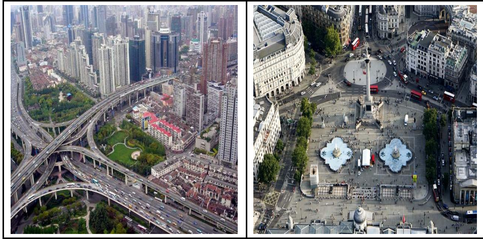
Şekil 36. a). The Puxi Viaduct, Şanghai, Çin, (URL-52, 2013), b). Trafalgar Meydanı, Londra, (URL-53, 2013)
