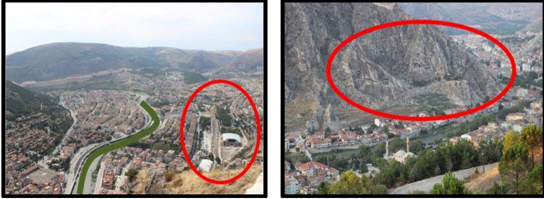
Şekil 67. Ulaşım güzergahlarında yeşil sürekliliğin olmaması ve Kral Kaya Mezarları'nın görünümü (Kurt, 2013)
