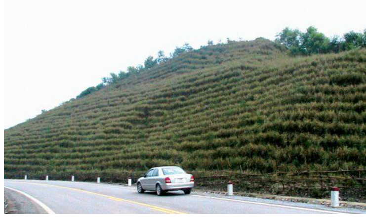
Şekil 46. Vietnam’da Ho Chi Minh yolunun bir kısmı Vetiver bitkisi ile canlı çitler oluşturularak stabilize edilmiştir (URL-27).
