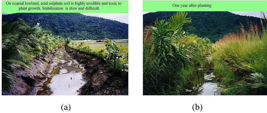
Şekil 12. Yüksek kirlilik seviyesine sahip ağır metallerle çevrili bir alanın a) Vetiver bitkisi ile bitkilendirilmesi ve b) bir yıl sonraki bitkilendirilmiş durumu ( URL-7).
