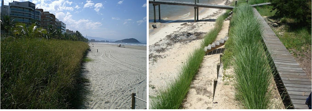
Şekil 23. Vetiver bitkisi ile kıyı/sahil koruma (URL-13)
