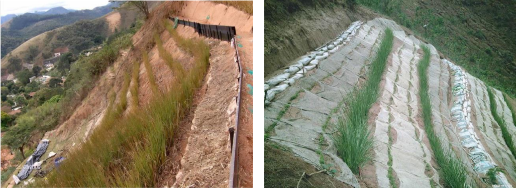
Şekil 24. Vetiver bitkisi ile toprak kayması/heyelan kontrol (URL-14)
