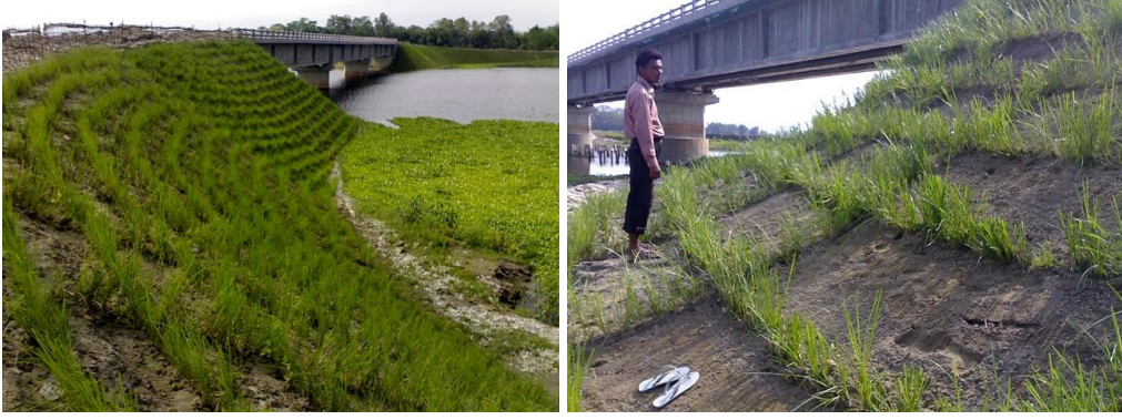
Şekil 22. Vetiver bitkisi ile köprü ayağını dengede tutma (URL-12)
