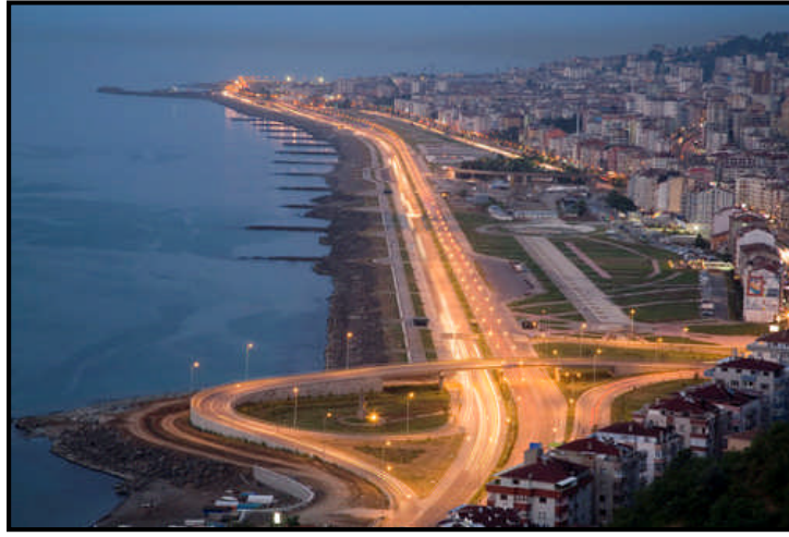
Şekil 3. Trabzon Şehrinden Bir Görünüm (URL-7)
