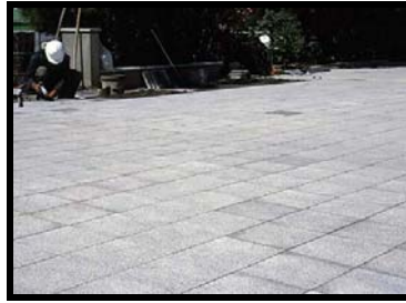
Şekil 33. Kaldırım Karosu Kaplama (URL-27)
