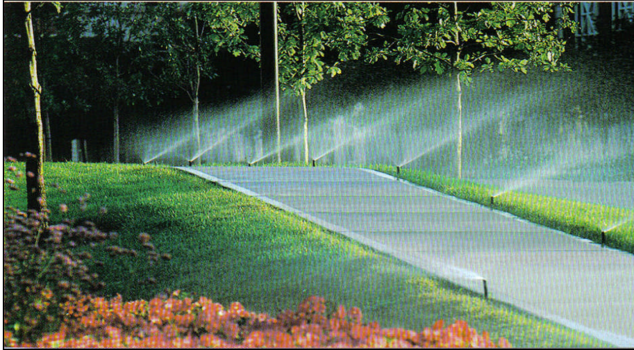
Şekil 14. Yol kenarı yağmurlama başlıkları ıslatma deseni [48].
