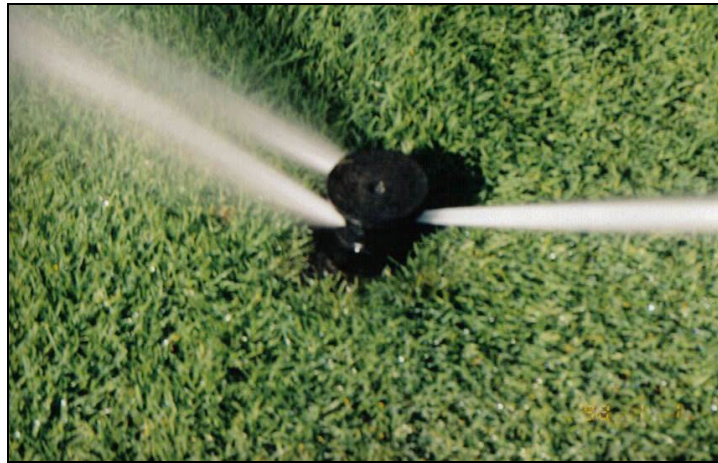
Şekil 18. Püskürtücü (Spray) Pop-up başlıklı sistem elemanı
