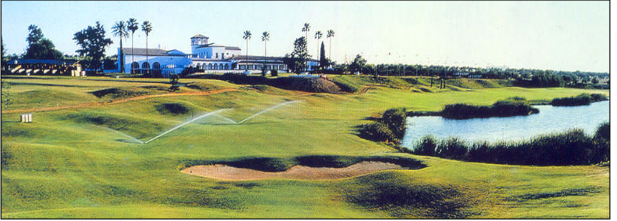
Şekil 10. Açık alandaki yağmurlama sulama sistemi [40]
