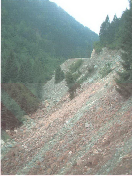
Şekil 29. Erikbeli Yayla yolunun genişletilmesi sonucu oluşan moloz yığını
