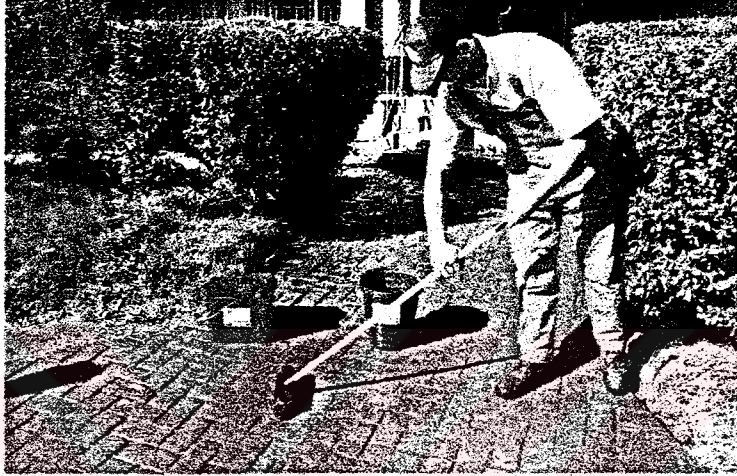
Şekil 27. Dekoratif dökme beton kaplamada yıkama-temizleme (24).
