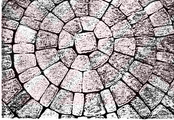
Şekil 46. Beton parke taşı uygulama örneği (33).
