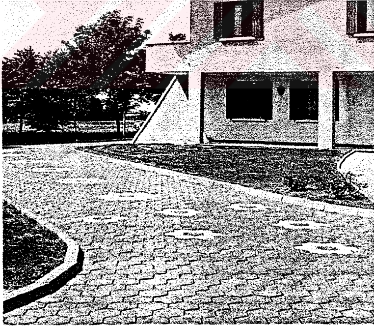
Şekil 41. Petektaş kaplama uygulaması (29).
