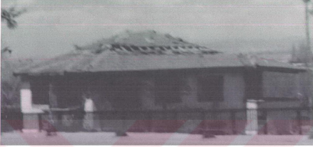
Şekil 7. Ankara Dikmen'de vandalizm eylemine maruz kalmış terkedilmiş bir yapı örneği
