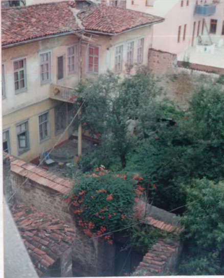
Şekil 3.66. Bahçe Duvarının Örtüsü
