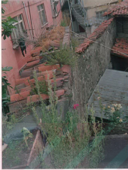
Şekil 3.65. Bahçe Duvarının Örtüsü
