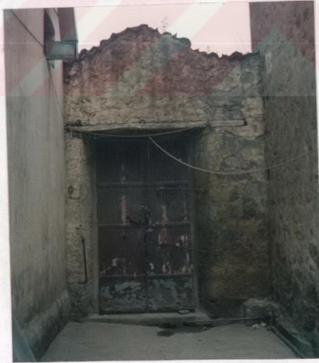
Şekil 3.54. Bir Konutun Bahçe Giriş Kapısının İçten Görünüşü
