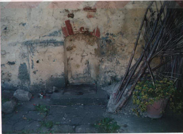
Şekil 3.84. Bahçe Duvarına Bitişik Kuyu + Çeşme
