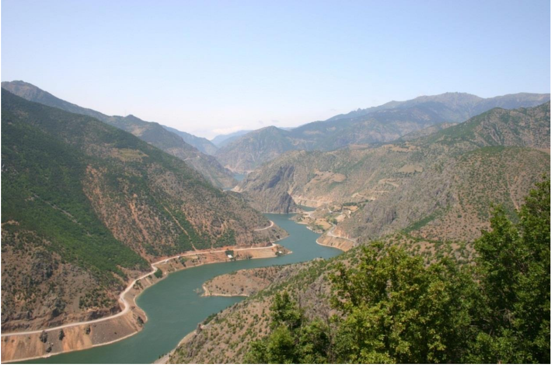
Şekil 3. Çalışma alanının batı-doğu istikametinden genel görünüşü
