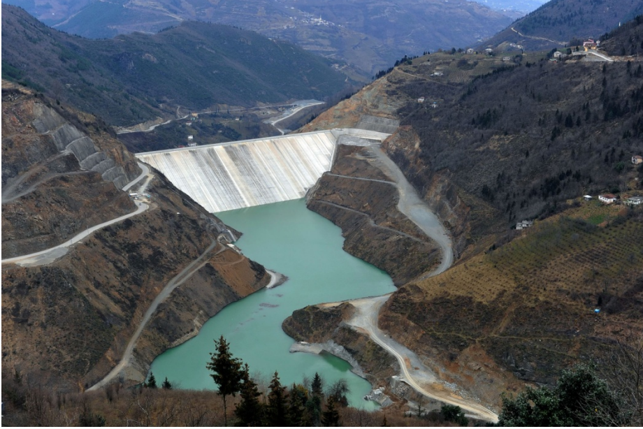
Şekil 3. Atasu barajından bir görünüm
