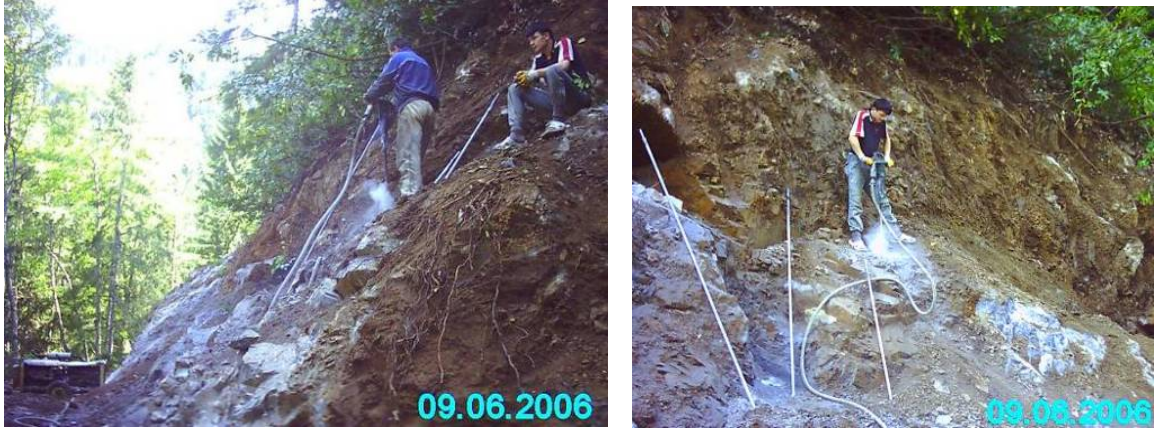
Şekil 38. AD-3 nolu atım yerinde kompresörle patlatma deliği açılması
