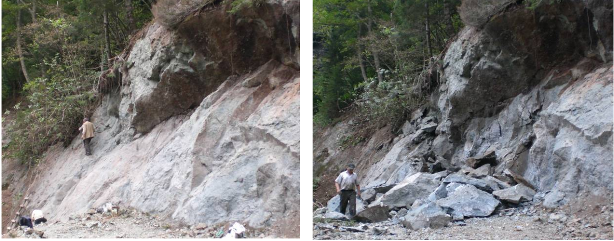
Şekil 45. Atım yerinde patlayıcı şarjı ve patlatma sonrası oluşan blok boyutu
