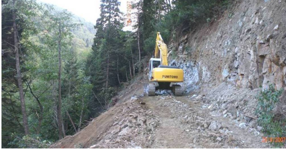
Şekil 41. Şalpazarı OİŞ orman yolu yapımı alanında kullanılan hidrolik ekskavatör
