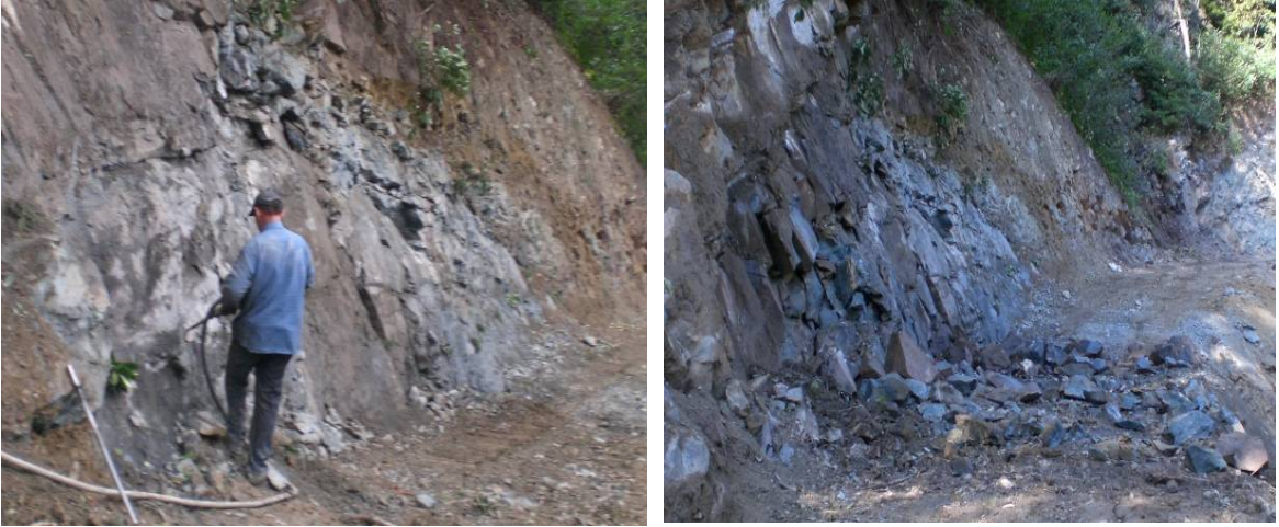
Şekil 56. SP-8 no'lu atım yerinde patlatma delikleri ve patlatma sonrası durum
