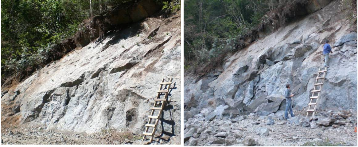
Şekil 48. SP-4 Nolu atımda patlatılma öncesi ve sonrasına ait genel görünüm
