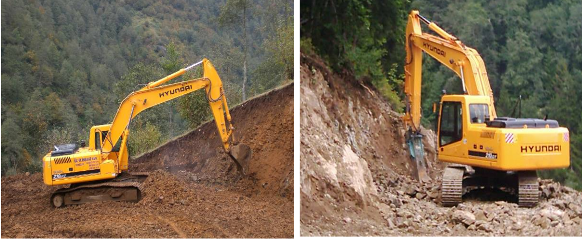
Şekil 17. Orman yolu yapımında hidrolik ekskavatörle toprak ve kaya kazısı
