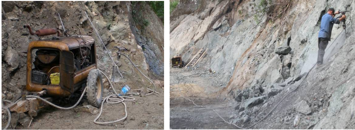
Şekil 18. Pnömatik (havalı) kompresörle patlatma deliklerinin delinmesi
