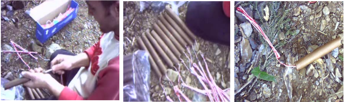
Şekil 33. Jelatinit dinamitlere elektrikli kapsül yerleştirme
