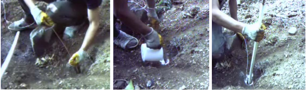
Şekil 34. Patlayıcı maddenin deliklere şarjı ve sıkılama
