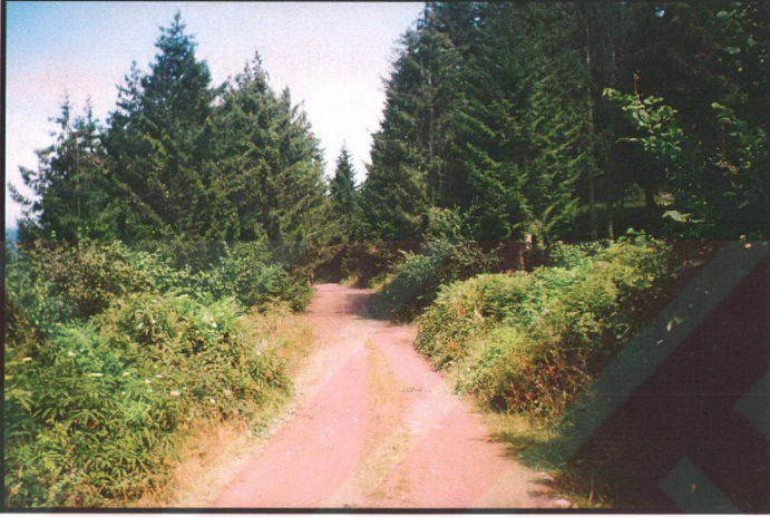
Şekil 46. III. Alana ait stabilize bir yol görünümü
