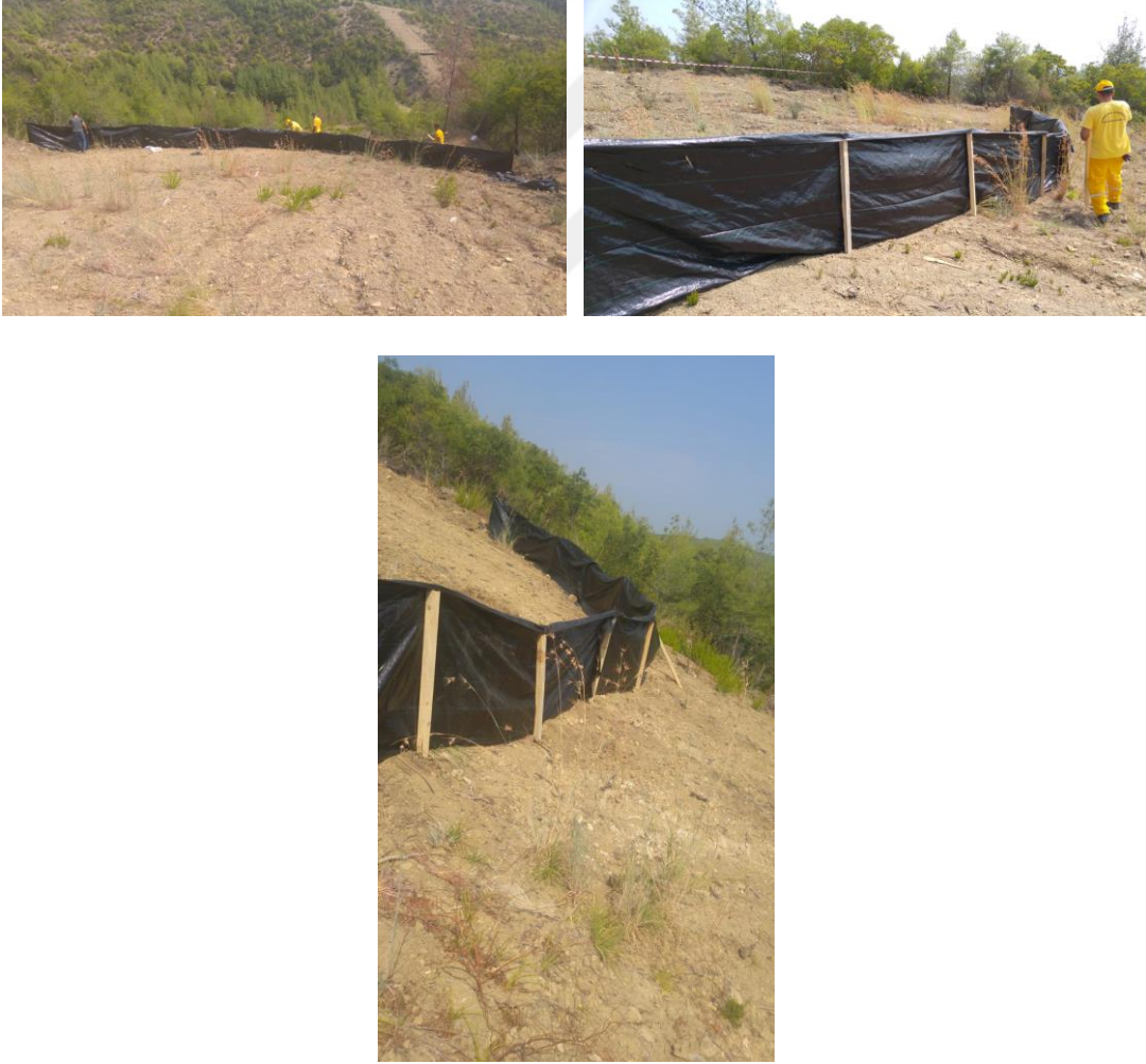
Şekil 7. Geotekstil (Silt fences) kurulumu
