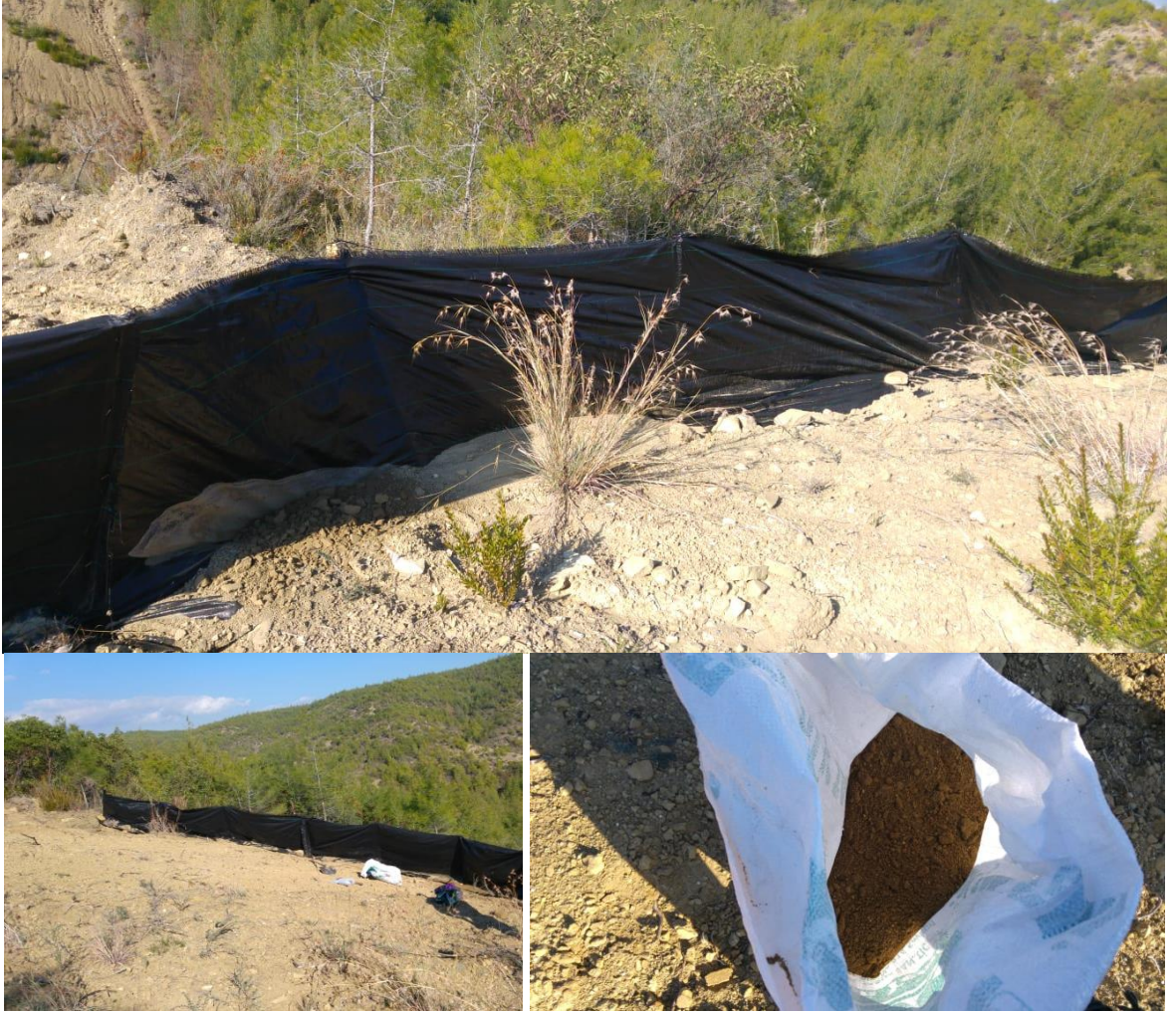
Şekil 8. Geotekstil (Silt fences) arkasında biriken toprakların alınması
