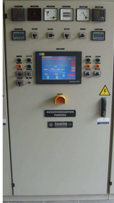
Şekil 2.17. Senkronizasyon panosu
