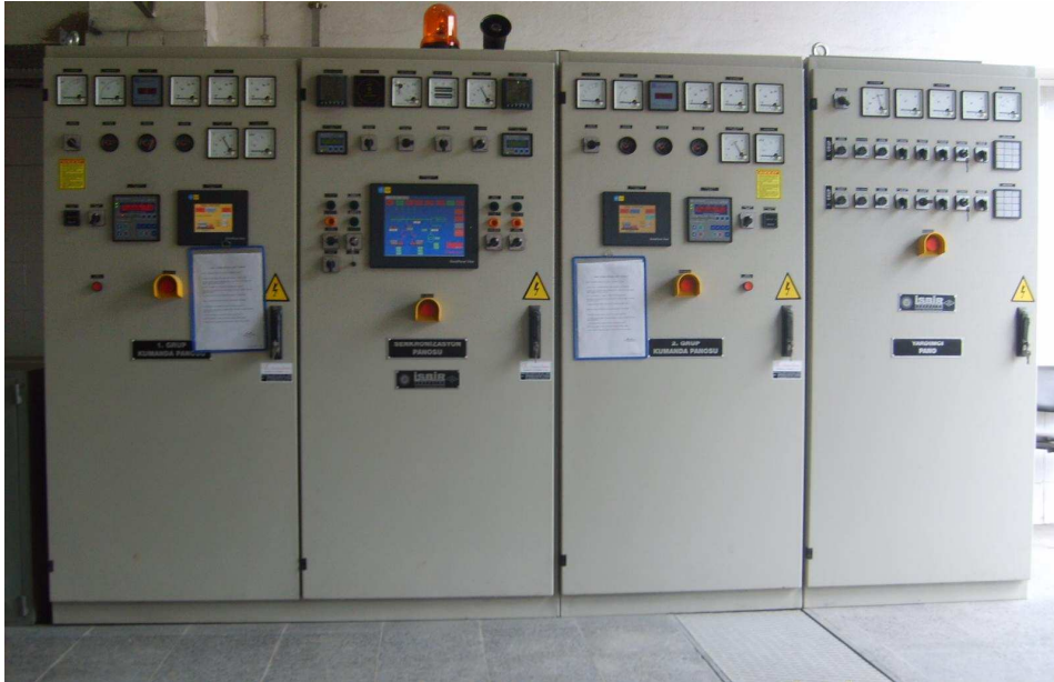
Şekil 2.14. Generatör otomasyon panoları
