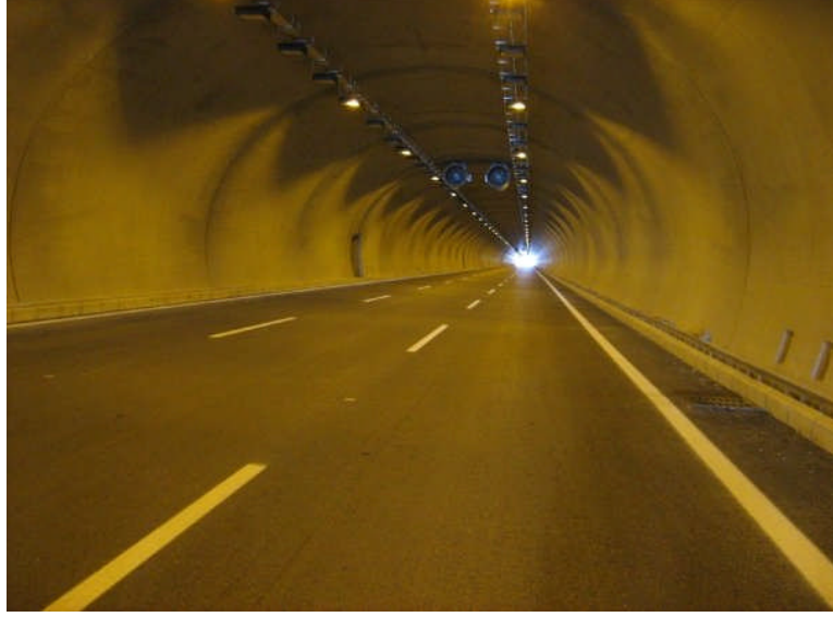
Őekil 9. İ  b lge aydınlatması
