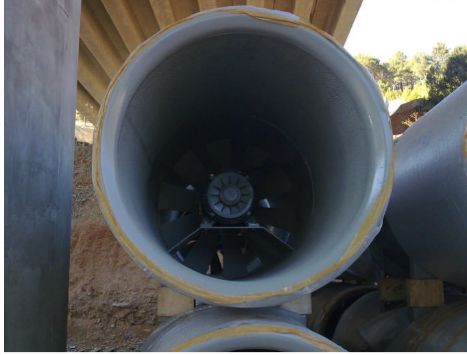
Şekil 14. Tünellerde kullanılan fanların önden görünüşü
