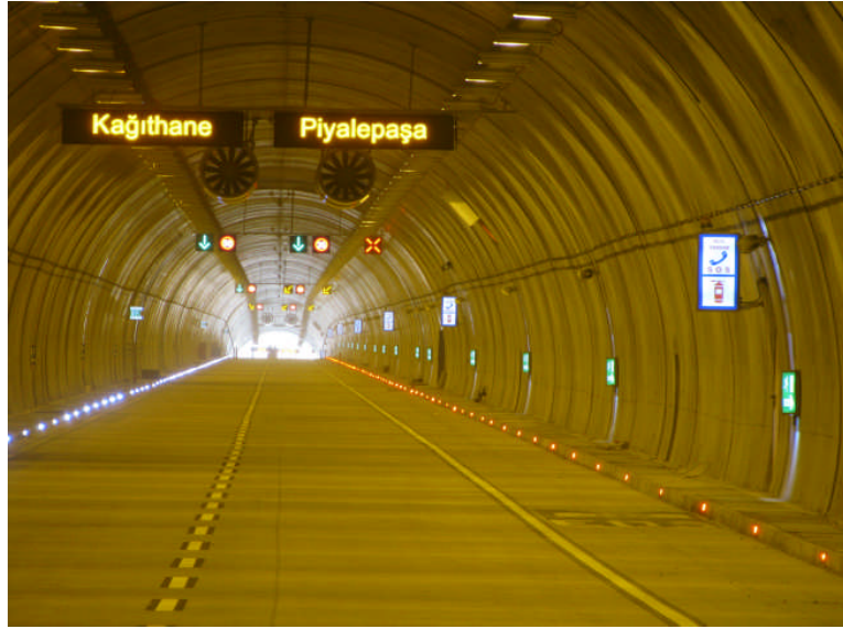
Şekil 12. İki şeritli yolda fan dizilişi
