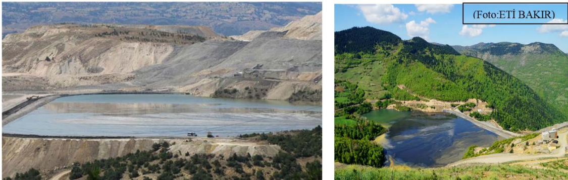
Şekil 10. Atık Barajı Civarı Rehabilitasyon ve Ağaçlandırma Çalışmaları Eski Hali ve Yeni Hali Karşılaştırması
