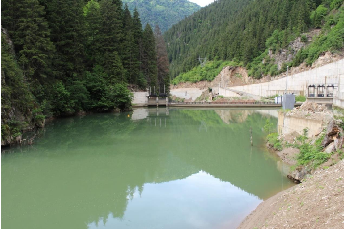
Şekil 35. Biriktirmeli baraj tipi regülatör yapısına sahip hidroelektrik santral
