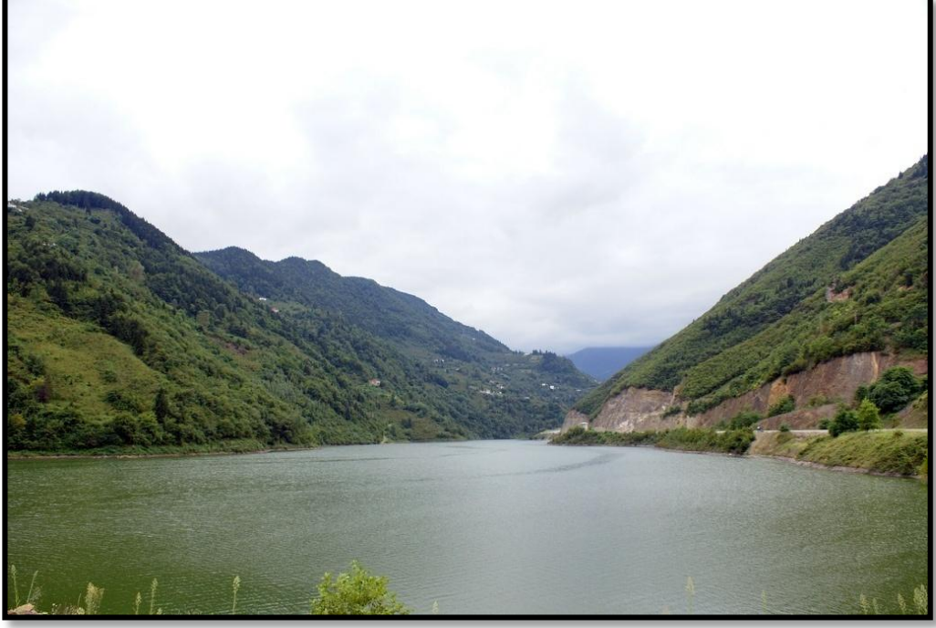
Şekil 3. Atasu barajından bir görünüm
