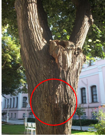
Şekil 12. Dolmabahçe Sarayı'nda plastik boru ile yapılan restorasyon örneği
