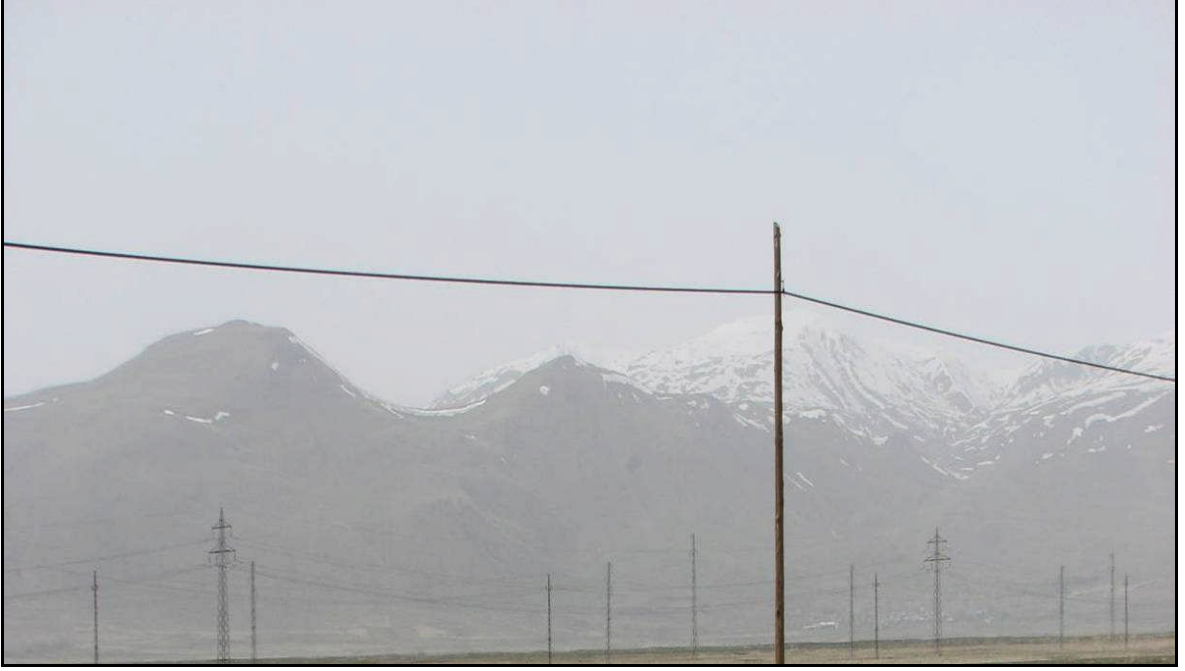
Şekil 28. Araştırma alanından geçen yüksek gerilim hatlarından bir görünüm
