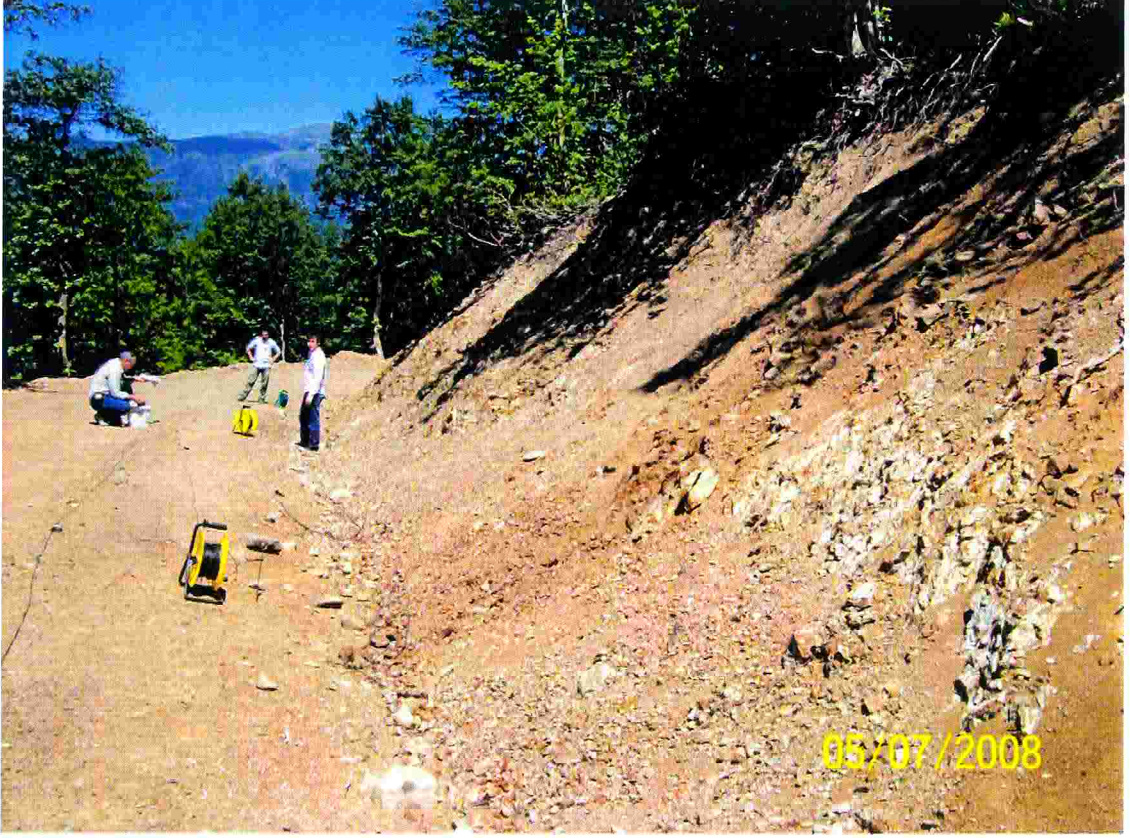
Şekil 22. Yol güzergahı boyunca yapılan elektrik özdirenç ölçümü
