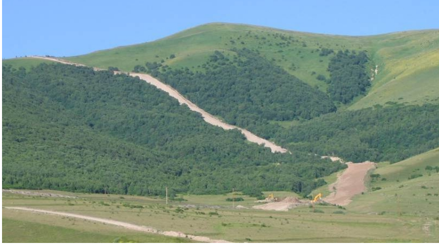
Şekil 51. Petrol boru hattı inşaatı
