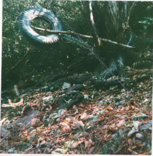
Resim 5.2: Cogla Üretim Alanında Vadi İstasyonunda Ane Halatın Sabitleştirilmesi (Foto: Acar)
