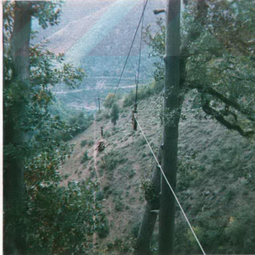
Resim 6.3: Çukur Üretim Alanında Kurulu Bulunan Hava Hattı ile Yapraklı Yakacak odunları Taşınması (Foto:Acar)
