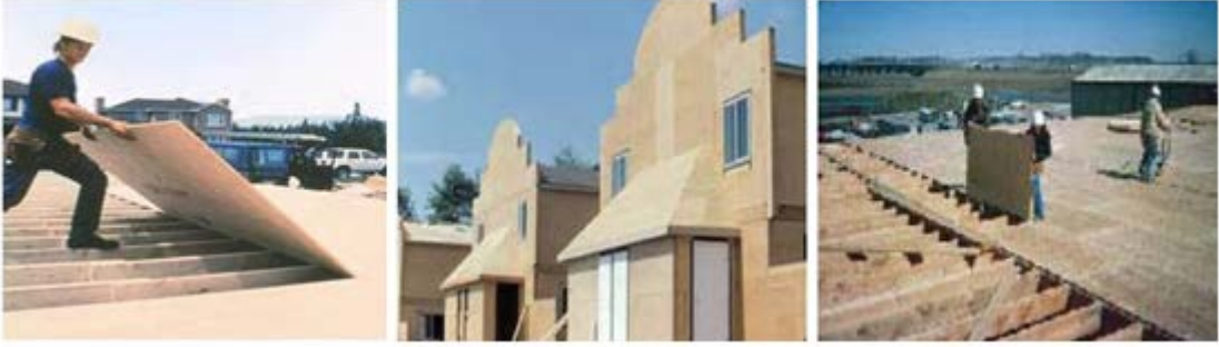
Şekil 16. Yapıda zemin, duvar ve çatılarda kontrplakların kullanımı
