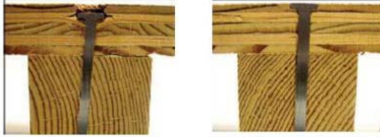
Hatalı Çakılmış Bağlantı Elemanı Düzgün Çakılmış Bağlantı Elemanı
