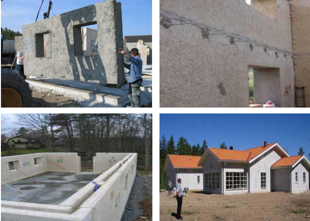
Şekil 14. Monoblok bina yapımında kullanılan büyük boyutlu WWCB duvar elemanları [39, 40].
