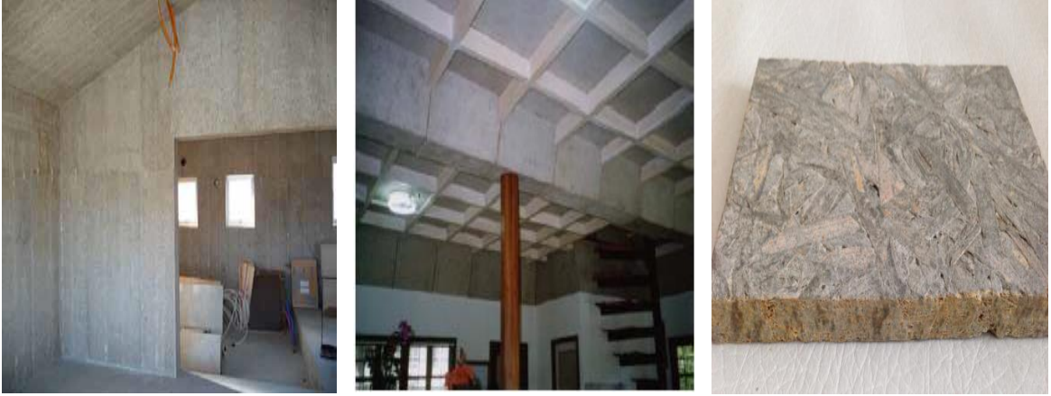
Şekil 9. WSCB levhalarının çatı, zemin ve duvarda kullanımı [25, 37].
