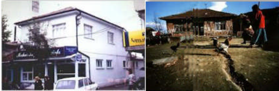
Şekil 1. Adapazarı depreminde ayakta kalan ahşap konutlar
