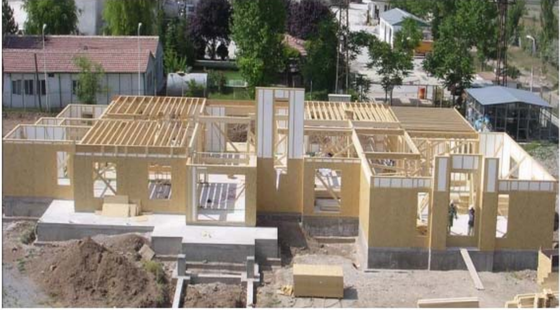
Şekil 3. Ahşap panel sistem (Ediz, 2018)
