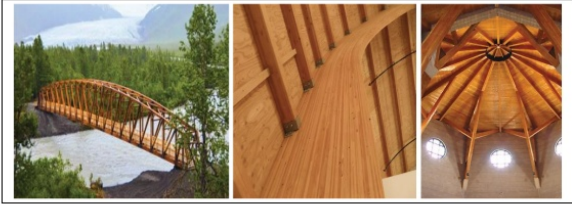
Şekil 9. Glulam ile yapılmış köprü ve kavisli çatı (APA, 2017).
