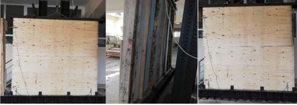
Şekil 42. 14. Duvarda oluşan hasar görünümleri
