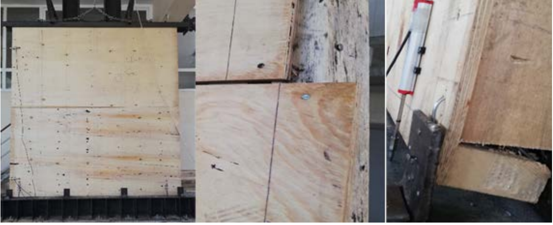
Şekil 41. 13. Duvarda oluşan hasar görünümleri
