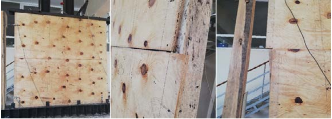
Şekil 37. 6. Duvarda oluşan hasar görünümleri
