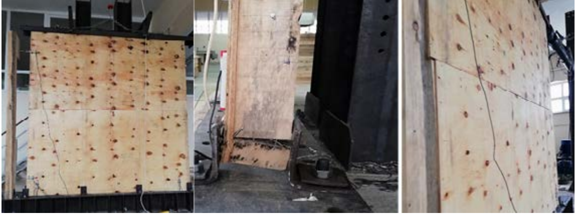
Şekil 32. 8. Duvarda oluşan hasar görünümleri
