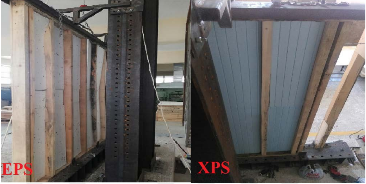
Şekil 15. Perde duvarların yalıtım malzemeleriyle kaplanması
