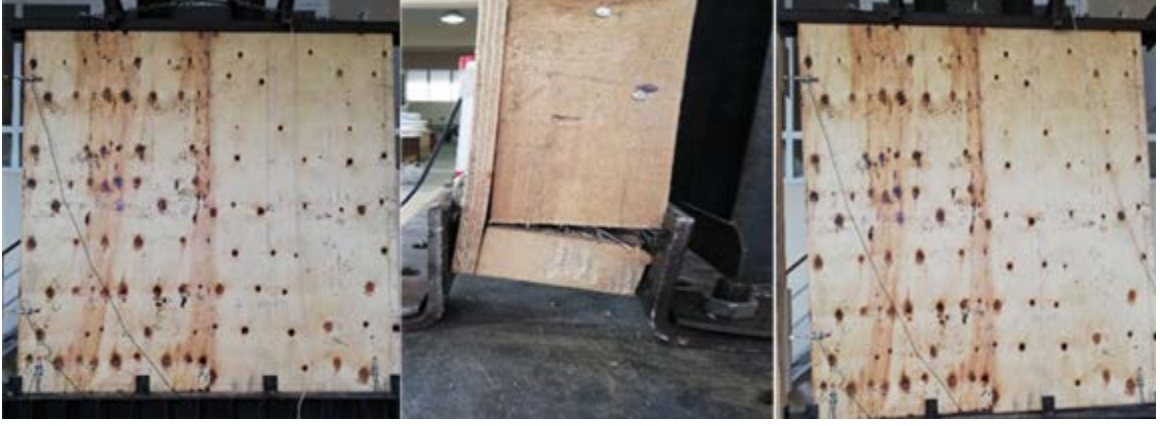
Şekil 31. 4. Duvarda oluşan hasar görünümleri
