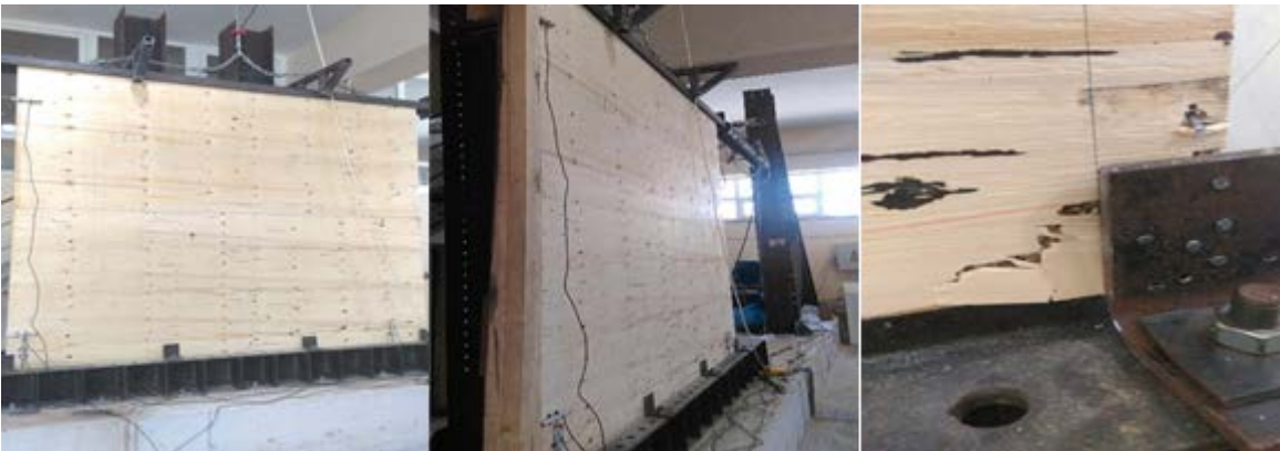
Şekil 43. 16. Duvarda oluşan hasar görünümleri
