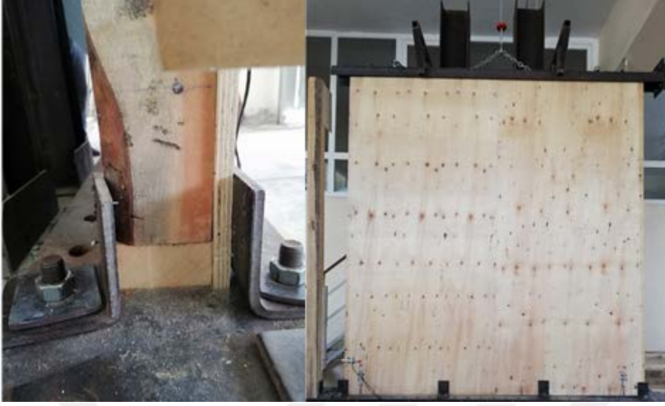
Şekil 13. Bir perde duvar çerçeve sisteminin zemine montajı
