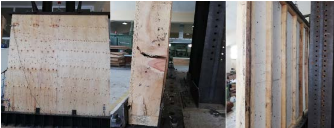
Şekil 40. 11. Duvarda oluşan hasar görünümleri
