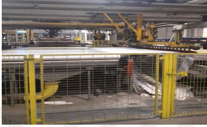
Şekil 36. Melamin pres emprenyeli kâğıt serme ünitesi
