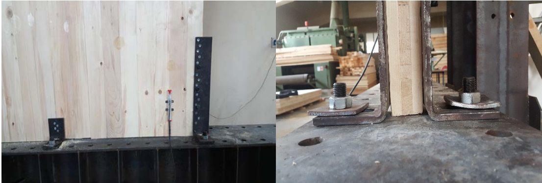
Şekil 34. CLT duvarların zemine montelenmesi
