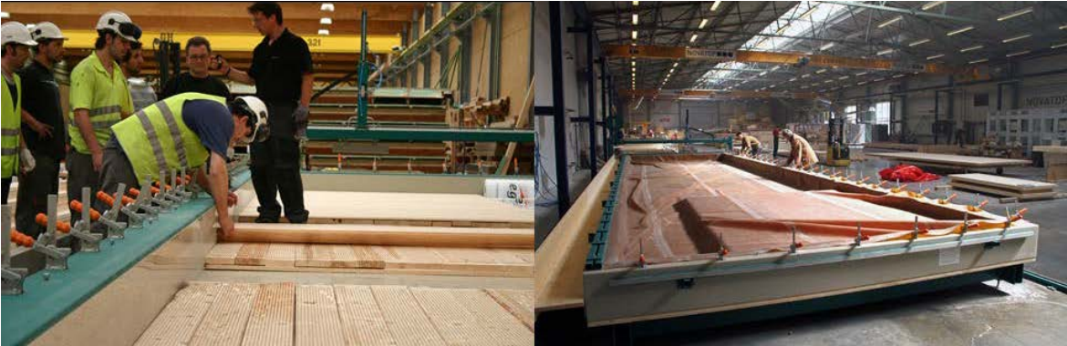
Şekil 20. CLT tabakalarına vakum pres uygulaması
