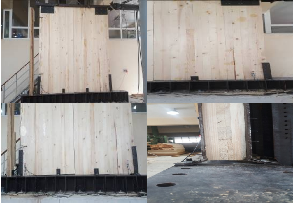
Şekil 57. Deney esnasında 6. grupta meydana gelen deformasyonlar
